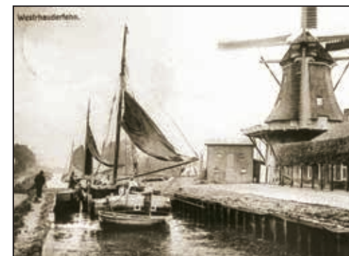
Ausschleusung Torfschiffe Westrhauderfehn in Richtung Hauptfehnkanal
