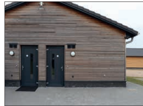
Das Sanitärgebäude an der Paddel- und Pedalstation.
