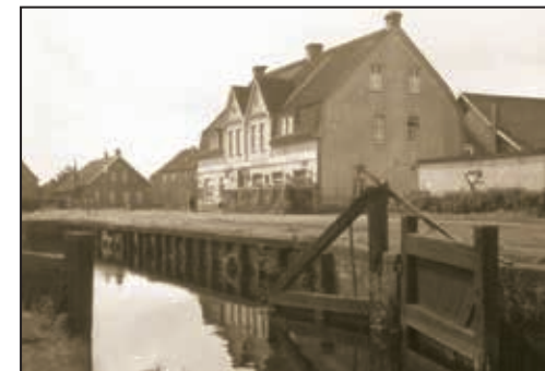
Verlaatshus mit alter Schleuse Westrhauderfehn
